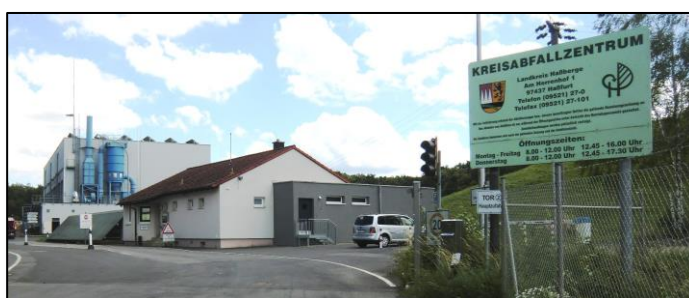
Abbildung 20: Einfahrt Deponie Wonfurt
